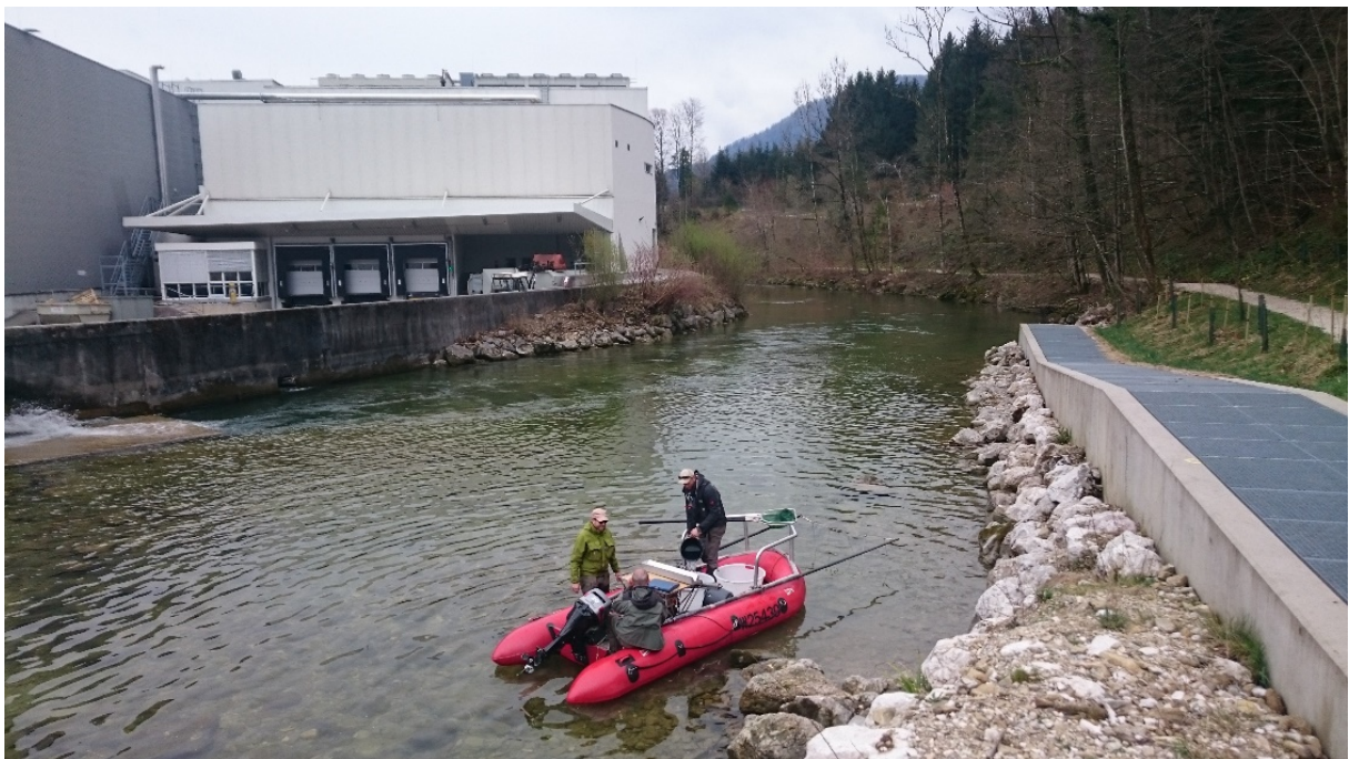
Abbildung 34: Streckenbild Seeache - Abschnitt 4; direkt unterhalb Kraftwerk Ebewe.
